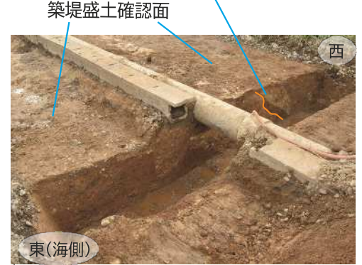
築堤盛土確認面
